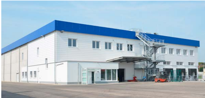
Das neue Logistikzentrum von Südwest fasst drei Lager an einem zentralen Standort auf dem Firmengelände zusammen. Mehr als 10 Mio. EUR wurden investiert.
